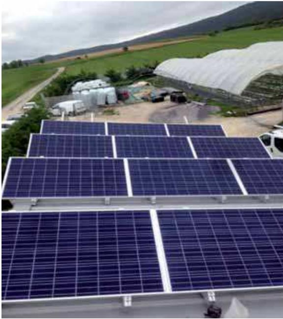
◀ Instalación fotovoltaica aislada en invernadero de fresas, 100% autónoma (toda la energía consumida en la explotación proviene del sol)
