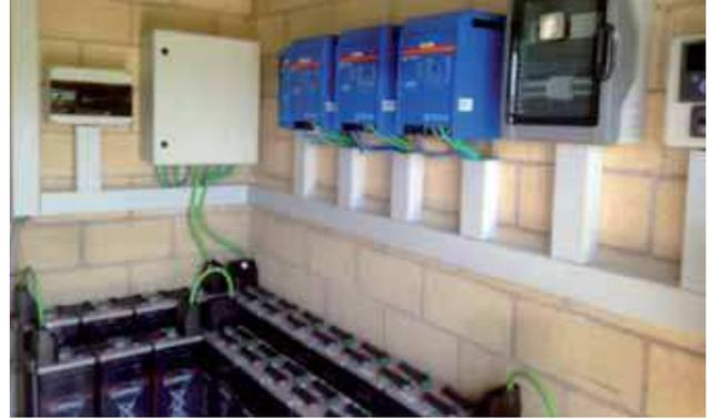
Instalación fotovoltaica aislada para bombeo solar, 100% autónoma (Toda la energía utilizada para el bombeo proviene del sol) ▶
