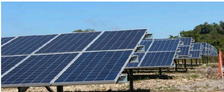
Vista de una planta fotovoltaica. (EFE)
